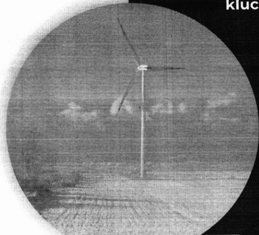
Park Wiatrowy w Darłowie, Realizacja i eksploatacja: Grupa Enerconet
